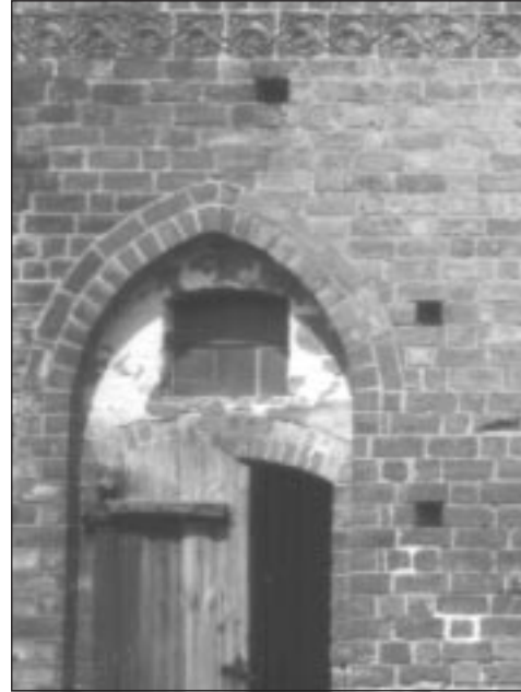
Abb. 2b: Ausgewählter Bereich einer Klinkerfassade (Südfassade des Brauhauses im Kloster Chorin)
